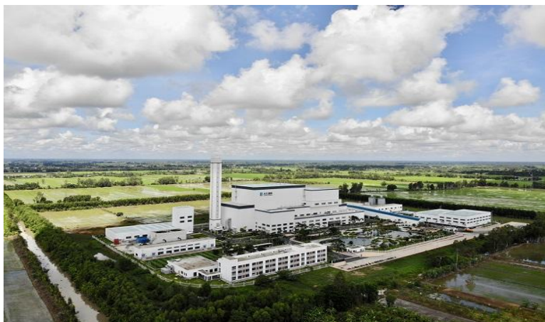
芹苴垃圾发电项目
