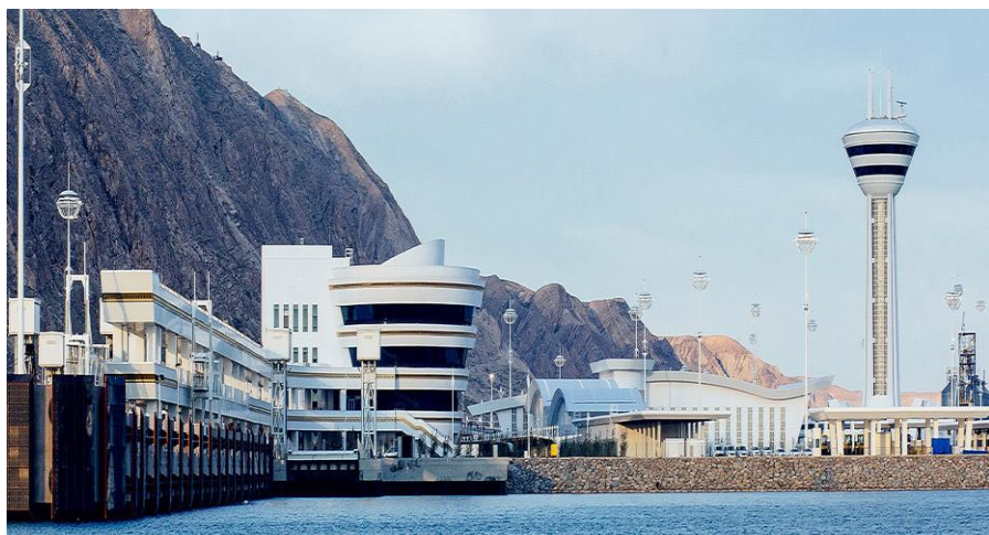
土库曼巴什新国际港口
