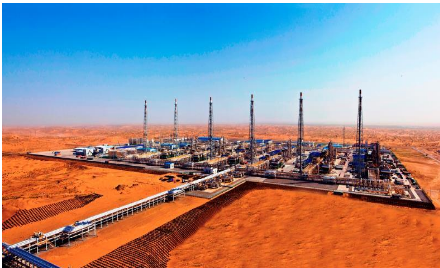
“复兴”气田一期第一天然气处理厂
