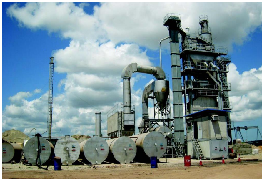
大连国际合作（集团）股份有限公司苏里南项目组拌和站
